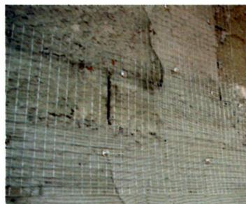
Telas metálicas eletrossoldadas zincadas a fogo para evitar fissuras entre alvenaria e estrutura. A tela inferior compõe um detalhe construtivo onde se pode utilizar um perfil de arremate de alumínio na requadrção da viga
