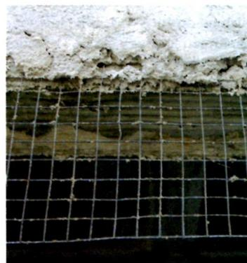
Tela metálica eletrossoldada zincada a fogo posicionada dentro do emboço na posição da requadrção de uma viga
