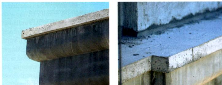
Detalhes das molduras em EPS mostrando proteção da laje superior. As molduras de EPS não devem ficar desprotegidas
